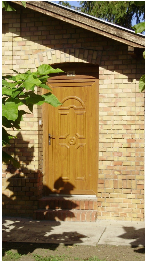
Új kiskapu régi építésű homlokzaton
