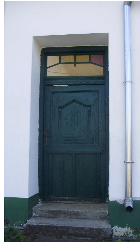
Eredeti kiskapu felújítása egy példaszerűen felújított épületen
